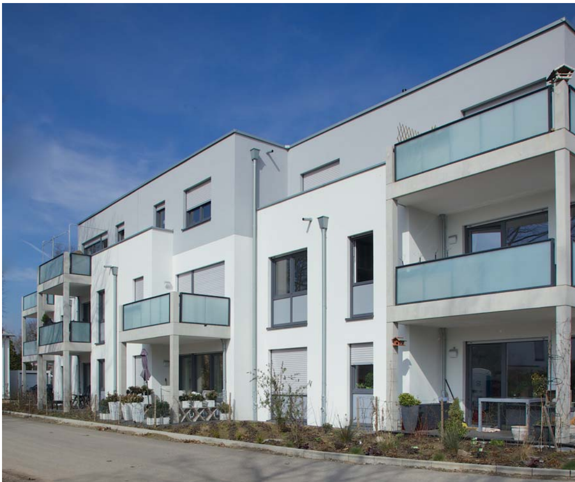
Neubau Bataverstraße 1, Kaarst-Büttgen
