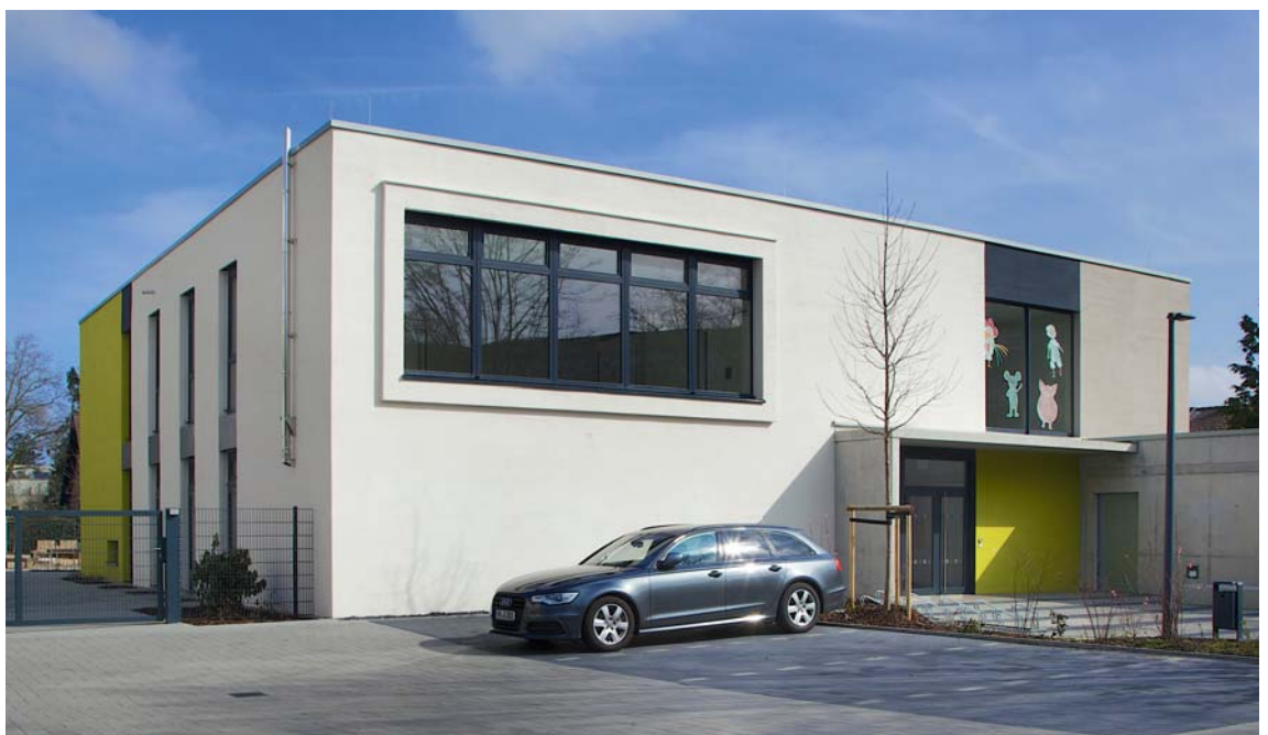
Neubau Kita Mullewapp, Eichendorffstraße, Neuss
