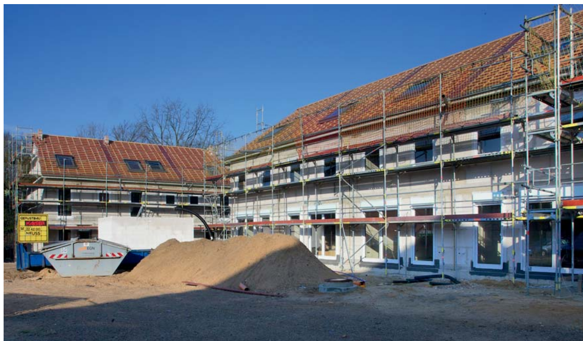
Neubau Einfamilienhäuser Augustastraße 38 – 42c, Neuss
