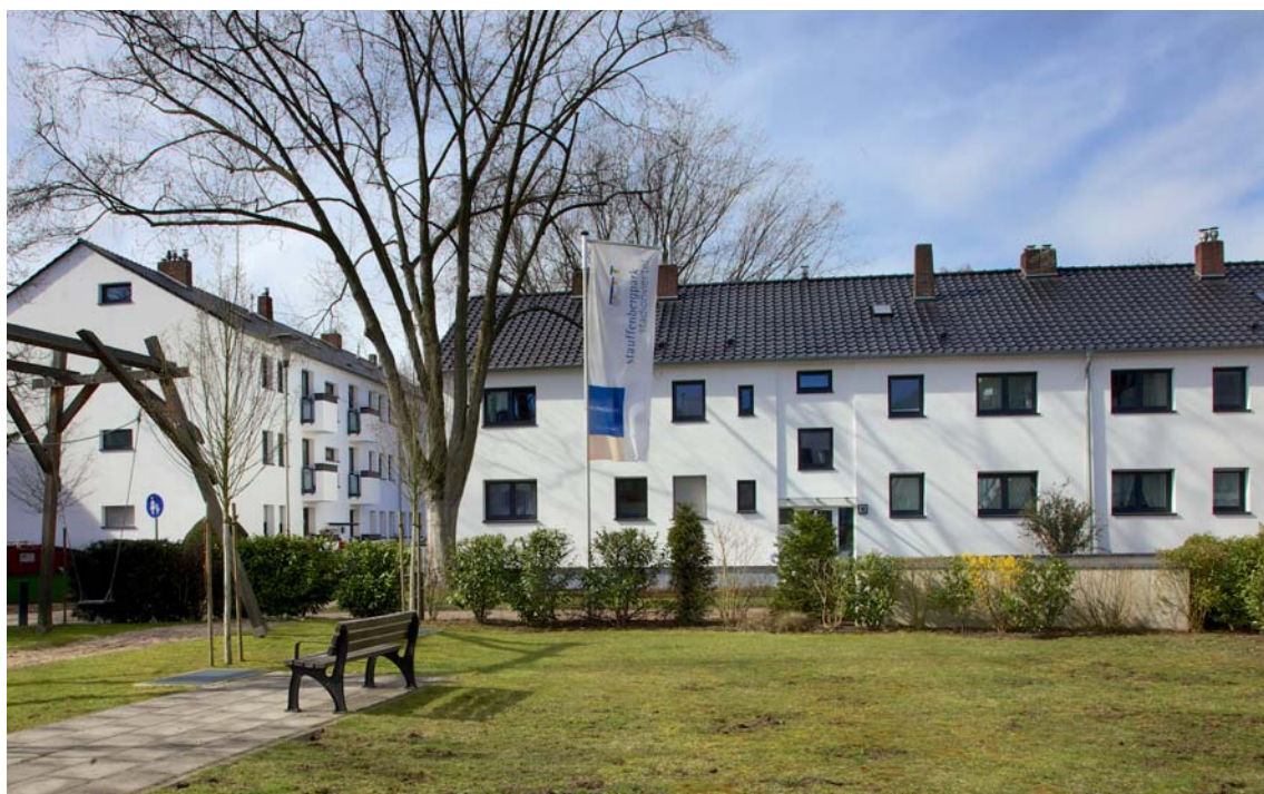
Energetische Sanierung Stauffenberg- und Bismarckstraße, Neuss
