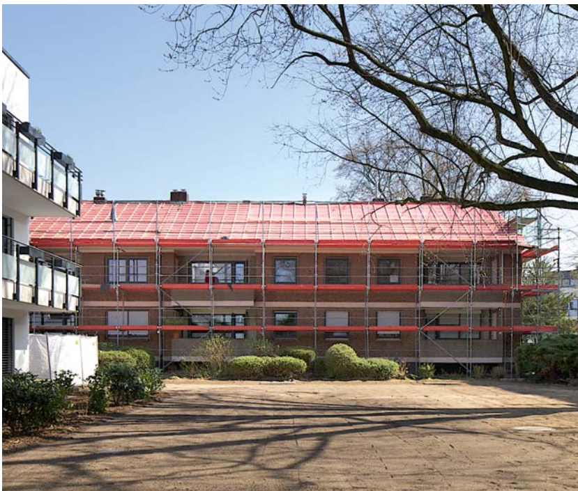
Energetische Sanierung Stauffenbergstraße, Neuss
