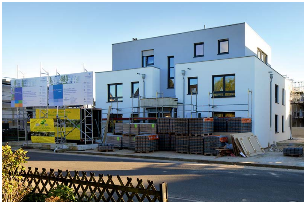
Neubau Römerstraße, Kaarst
