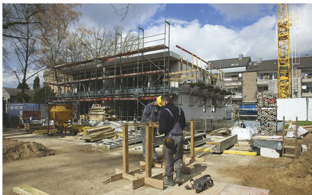
Neubau Stauffenbergstraße 10a, Neuss
