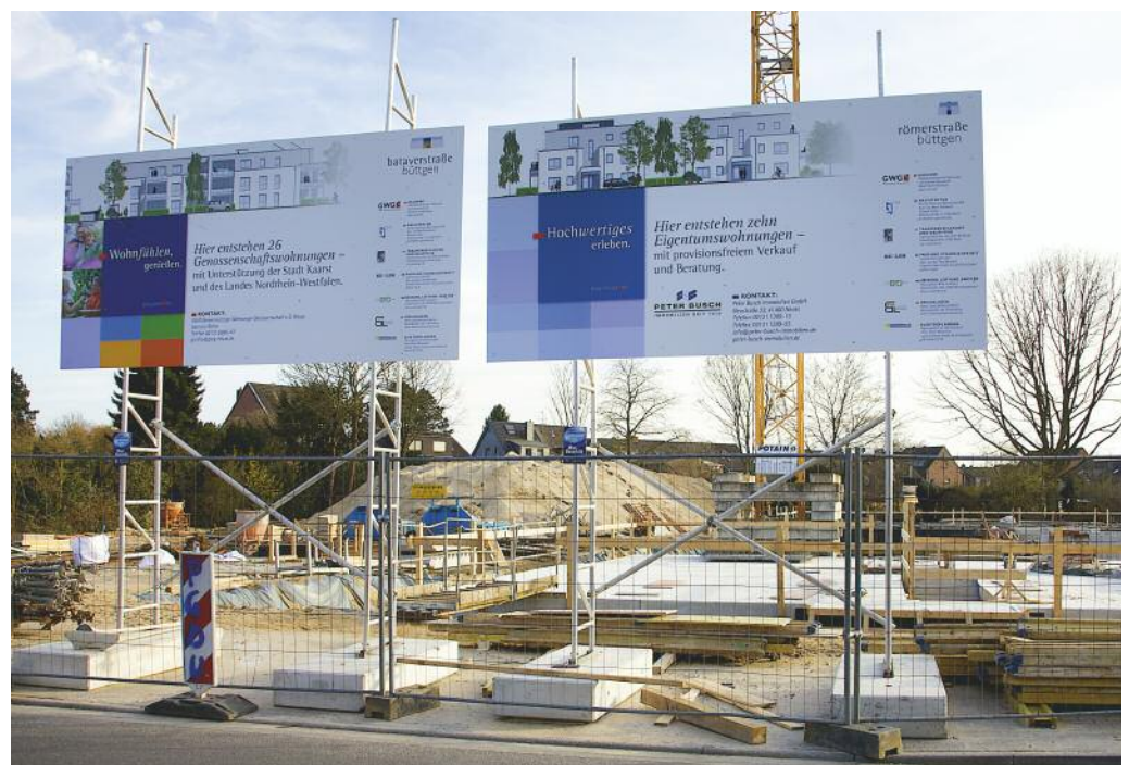
Baustelle Römerstraße, Kaarst
