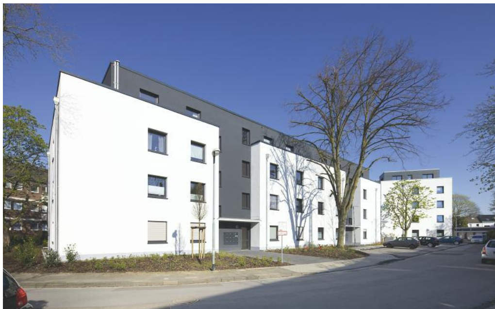
Neubau Stauffenbergstraße 3-4, Neuss
