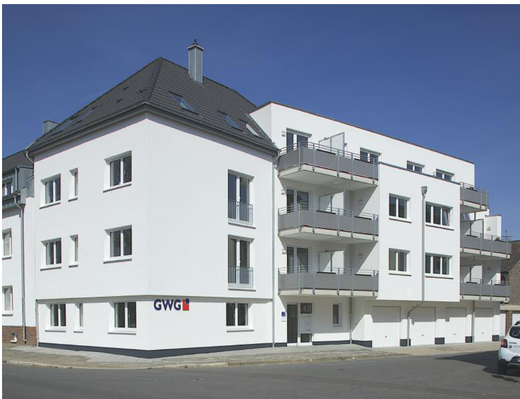
Neubau Viktoriastraße 43, Neuss
