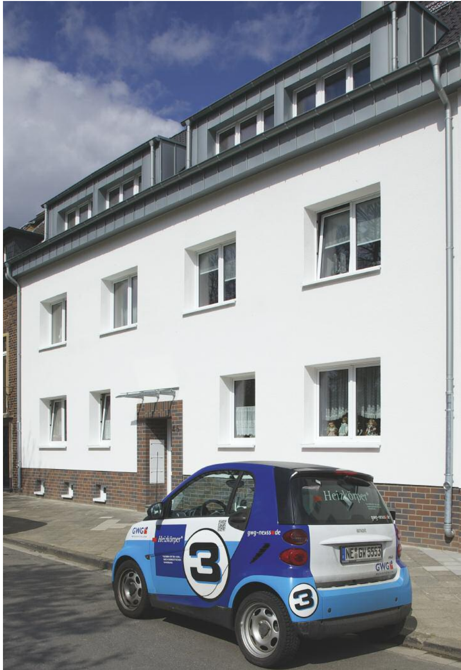
Energetische Sanierung Viktoriastraße 45, Neuss
