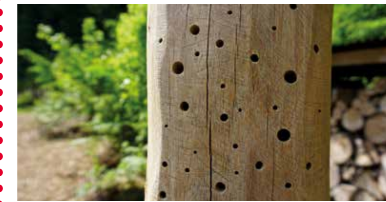
Immer ins Längsholz bohren!
